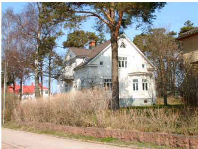
Hamngatan 5 (vandring 4, nr 55 norra huset)
