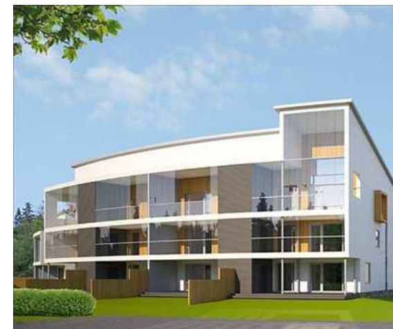
Fondvägg i träpanel och genomskinliga räcken
