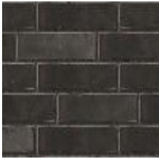
Bild 3.2.1 Med schattering avses att de enskilda fasadtegeln kulör varierar något. Detta ger en varierad och mera livfull muryta.
