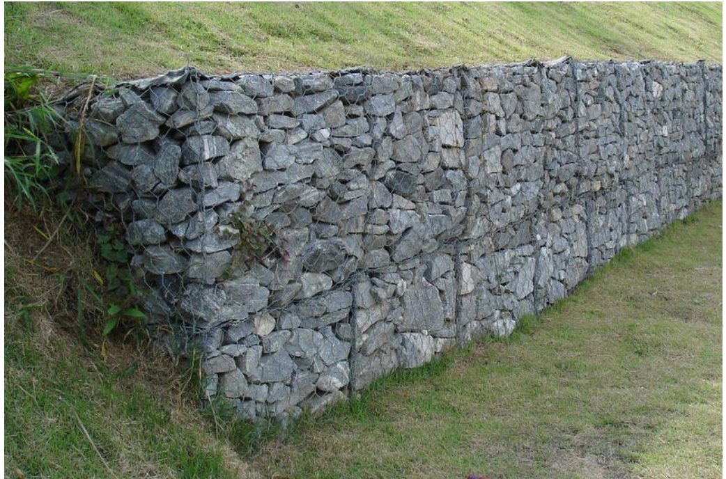
Bild 4.6.3 Gabionmurar består av ett hölje av metallnät fyllt med stenmaterial
