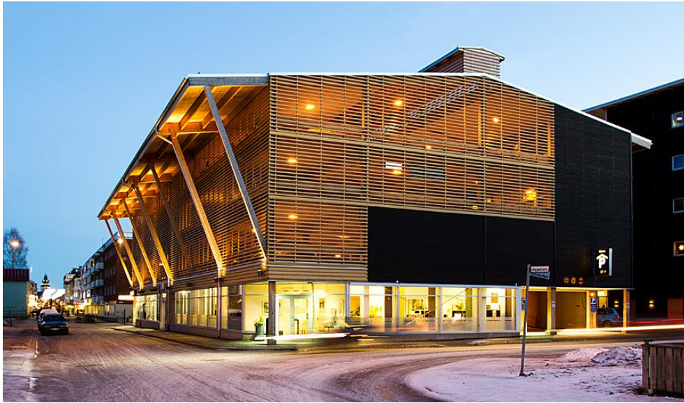
Figur 4-30 Parkeringshuset Ekorren i Skellefteå är ett bra exempel på en modern parkeringsanläggning som smälter in i stadsbilden. Foto: martinssons.se
