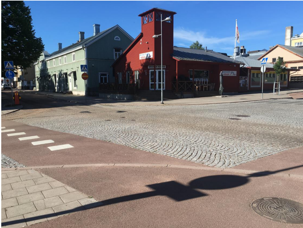
Figur 2-8 I de centrala delarna har hastighetssäkrande utformning införts i flera korsningar. Bilden ovan är från korsningen Strandgatan/Nygatan. Foto: Malin Gibrand
