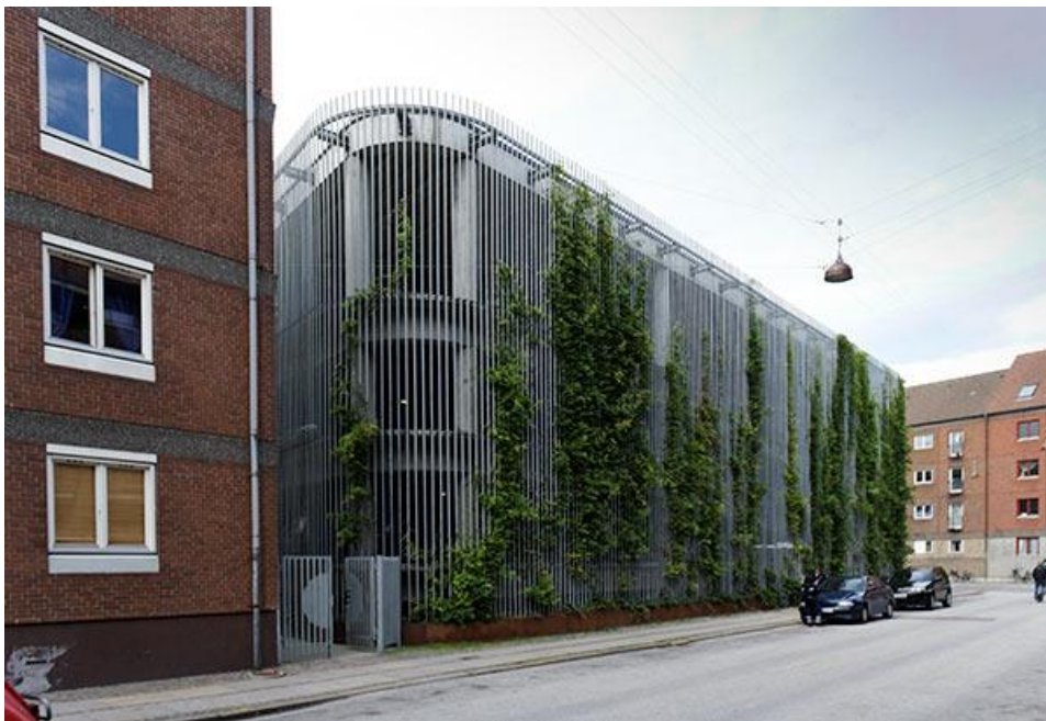
Figur 4-33 Parkeringshus i Malmö.
