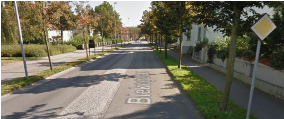
Figur 4-19 Referens från Ystad som har arbetet för att minska barriäreffekterna från sina större gator i staden genom införande av en överkörningsbar mittrefug av gatsten. Åtgärden har ingen påverkan på transportkapaciteten men tar ner upplevelsen av gatans bredd. Gatan är en huvudled med 50 km/tim som hastighetsbegränsning, separerad gång- och cykeltrafik, samt övergångsställen, likt Österleden.
