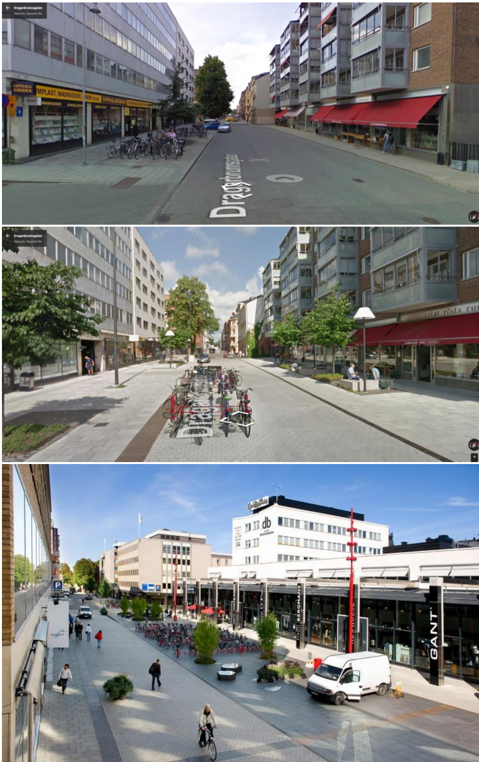
Figur 4-7 Referenser mjuktrafikrum. Den övre bilden visar Dragarbrunnsgatan före renovering med bred körbana och smal trottoar på högra sidan och utan särskilt mycket omsorgsfull design. Källa: Google maps De nedre bilderna visar Dragarbrunnsgatan efter renovering där trottoarerna har breddats, mer sittplatser, träd och cykelparkering, samt ett enhetligt golv som inte inbjuder till höga hastigheter. Motorfordonstrafik är tillåten men trafiken sker på de oskyddade trafikanternas villkor. Ett bra exempel på en gata där samtliga trafikanter får ta plats, men där gatan inte fungerar som genomfart för motorfordonstrafiken. Källa: Google maps & www.white.se
