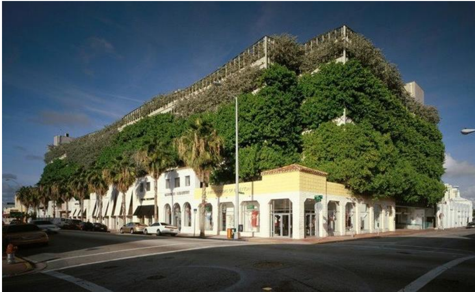
Figur 4-32 Ballet Valet Parking Garage, Miami Beach, USA. Omdaning av existerande art deco-byggnad till parkeringshus med lokaler i bottenvåning.
