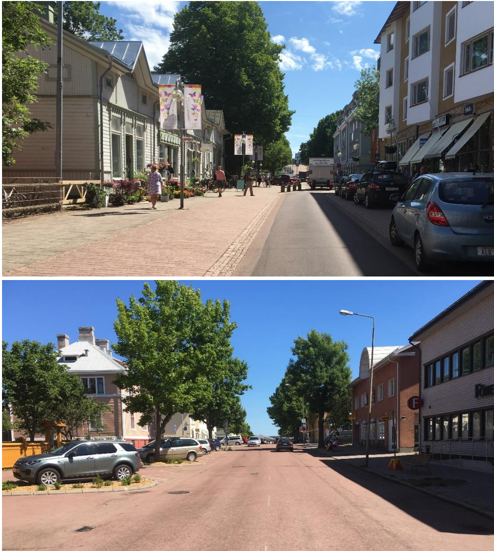
Figur 2-9 Fördelning av gaturummet påverkar gatans karaktär, vilket i sin tur påverkar gatans användning. Disponeringen av södra Torrgatans gaturum (överst) jämfört mot Nygatans gaturum (nederst). Foto: Malin Gibrand
