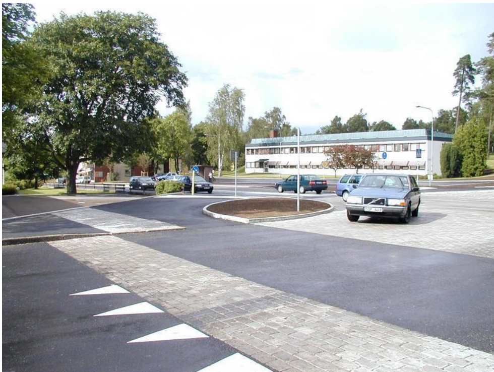
Figur 4-22 Referens Lessebo. Upphöjd korsning som en del av en större ombyggnad av genomfarten av väg 25 genom Lessebo i syfte att öka trafiksäkerheten med särskild tyngdpunkt på de oskyddade trafikanterna. Andel tung trafik är relativt hög.
