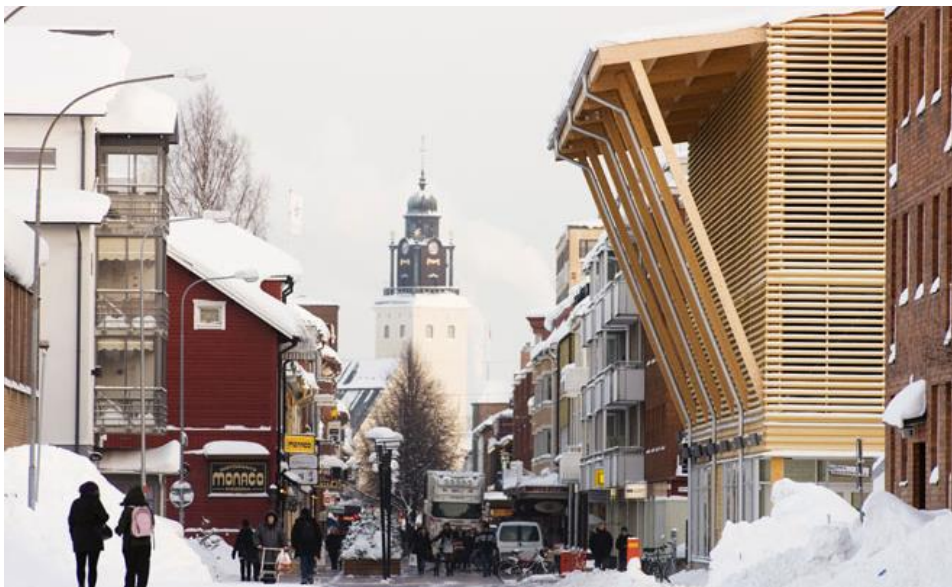
Figur 4-31 Parkeringshuset Ekorren är lokaliserat i början av gågatan i Skellefteå. Foto: martinssons.se
