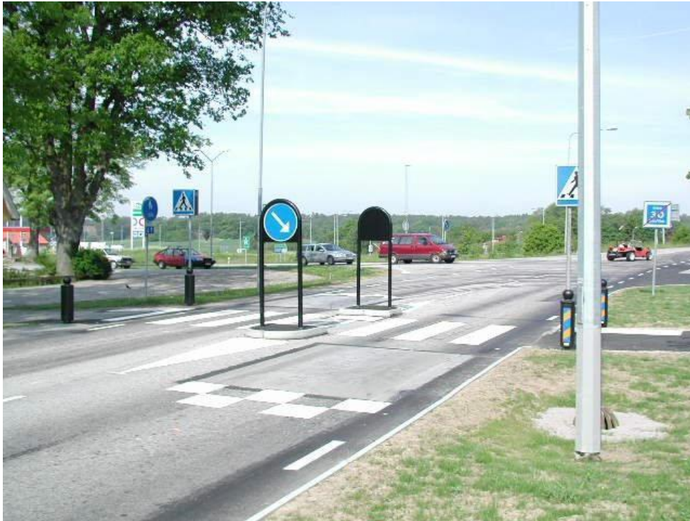
Figur 4-21 Referens Nätraby. Hastghetssäkrat övergångsställe med vägkudde. Farthinder i form av vägkudde är ett bra alternativ vid omfattande tung trafik förutsatt att den som här placeras vid en smal sektion.
