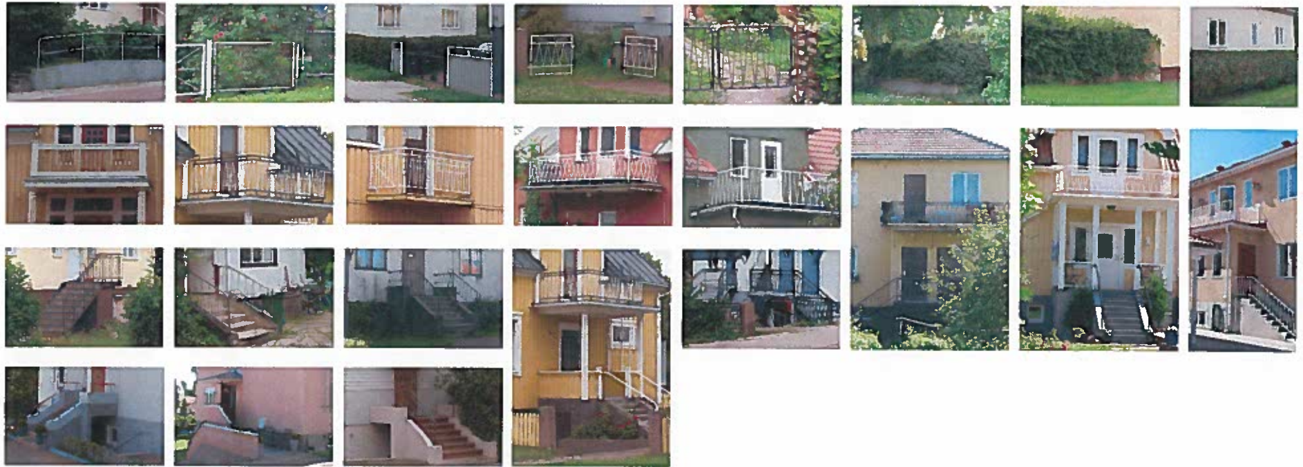
EXEMPEL PÅ BALKONG- OCH TRAPPRÄCK, HACKAR, STAKET OCH GRINDAR I OMRÅDET SVEDEN
