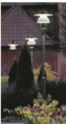
Bild 3.3.2 Hög belysningsstolpe med nedåtriktad belysning.
