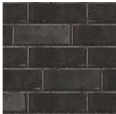
Bild 3.2.1 Med schattering avses att de enskilda fasadteglens kulör varierar något. Detta ger en varierad och mera livfull muryta.
