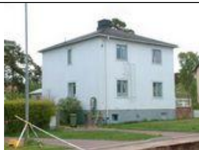
Torggatan 37 Byggnadsår/-lovår: 1950 Planerad av Erik Sjöblom
