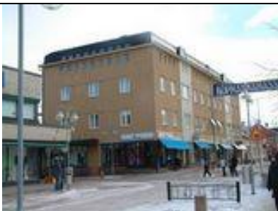
Torggatan 9 Boreniuskahuset Byggnadsår/-lovår: 1938 Planerad av byggm. Frithiof Lindholm Kategori B
