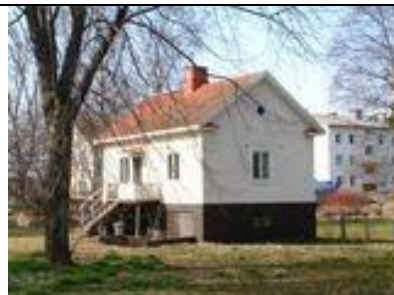
Havsgatan 28 Byggnadsår: 1939 Planerad av byggm. Frithiof Lindholm
