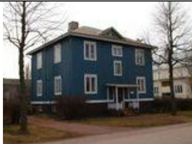
Mariegatan 5 Byggnadsår/-lovår: 1939 Planerad av L Lindblom
