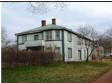
Neptunigatan 55 Byggnadsår: 1912, tillbyggd
