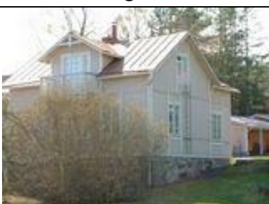
Godbyvägen 18 "Nyckelpigans hus" Byggnadsår: 1920
