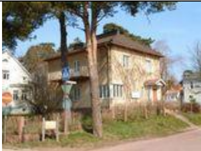
Hamngatan 6 Byggnadsår/-lovår: 1935 Planerad av byggm. Frithiof Lindholm
