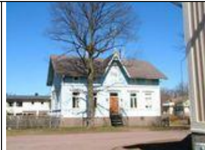
Mariegatan 20 Byggnadsår/-lovsår: 1900 Planerad av byggm. Hilda Hongell
