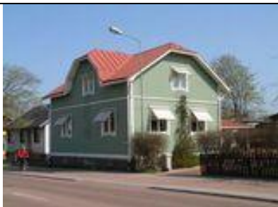
Ålandsvägen 75 Byggnadsår/-lovår: 1913 Planerad av B Gunell
