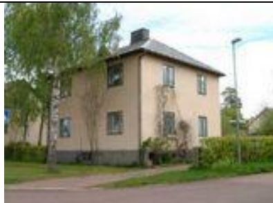
Torggatan 41 Byggnadsår/-lovår: 1942 Planerad av Erik Sjöblom
