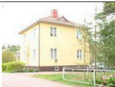
Lekgränd 3 Byggnadsår/-lovår: 1954 Planerad av byggm. B Lindblom
