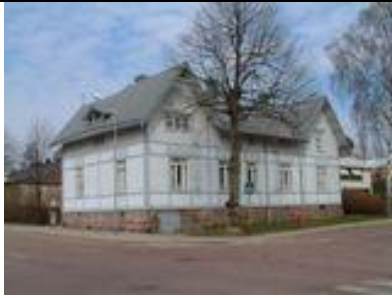
Norragatan 34 Byggnadsår/-lovår: 1907, tillbyggd på 1930-t Planerad av byggm. Hilda Hongell K-märkt 1985 Tomtbeteckning: Dalberg-4-10
