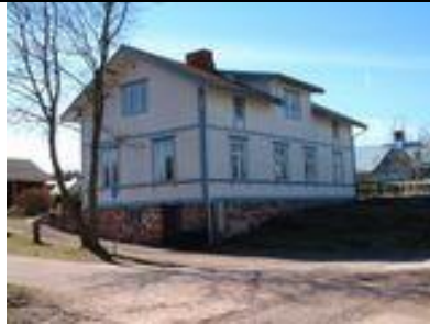
Mariegatan 15 Byggnadsår/-lovsår: 1899 Planerad av byggm. Hilda Hongell
