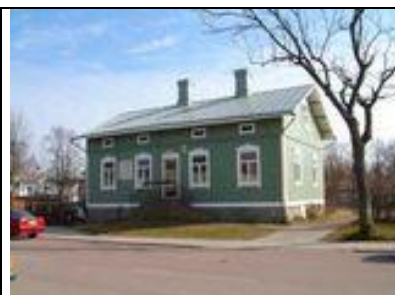
Norragatan 13 B Byggnadsår: 1891 Planerad av byggm. Hilda Hongell
