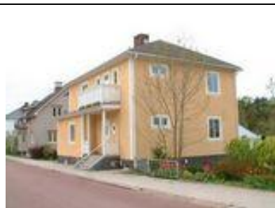
Torggatan 46 Byggnadsår/-lovår: 1942 Planerad av Erik Sjöblom
