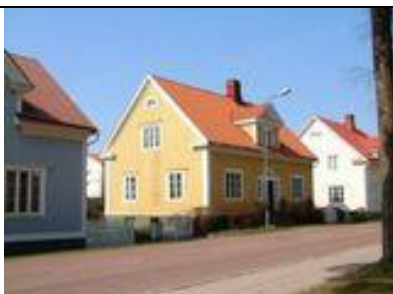
Havsgatan 16 Byggnadsår/-lovår: 1935 Planerad av Jac Lundqvist
