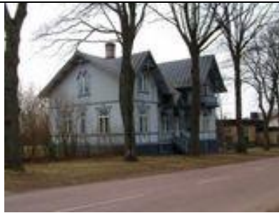
Södragatan 5 Byggnadsår: 1898 Planerad av byggm. Hilda Hongell
