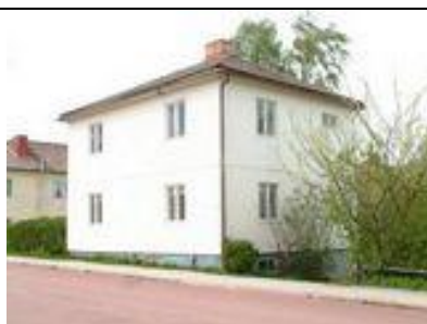
Torggatan 54 Byggnadsår/-lovår: 1945 Planerad av Erik Sjöblom
