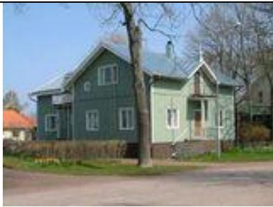
Mariegatan 36 Byggnadsår/-lovår: 1900 Planerad av byggm. Hilda Hongell
