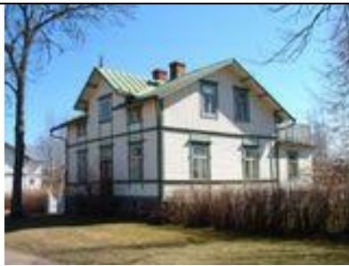
Södragatan 17 Byggnadsår: 1899 Planerad av byggm. Hilda Hongell
