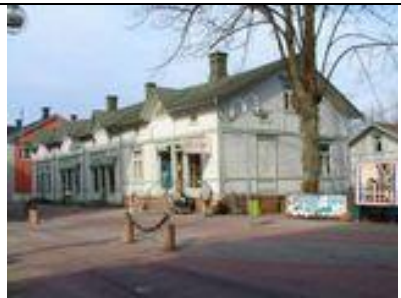
Torggatan 15 Byggnadsår: 1876+1921+1897 Planerad av ark. Oscar Bomanson
