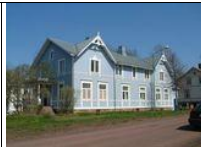
Mariegatan 14 Byggnadsår: 1898 Planerad av Hilda Hongell
