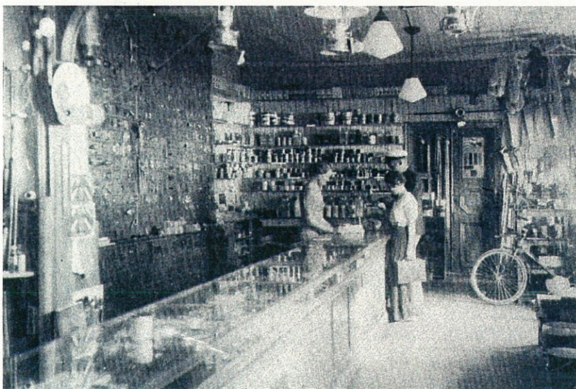
En butikinteriör från affärsfastigheten vid Strandgatan i Mariehamn, 1920. Jmf väggskåpet till vänster. Foto ur Ålands museums arkiv.
