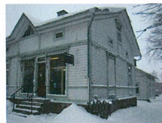
Byggnadens södra, i dag äldsta del. Foto 2010.
