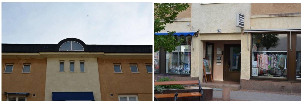
Figur 13–14: Lunettfönster ovanför takfot samt infällt vindfång från väster.
