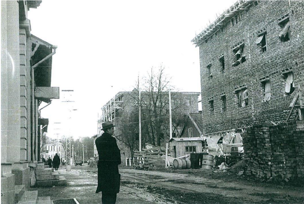
Figur 2: Boreniuska huset och Cityhuset under uppbyggnad. I förgrunden syns Boreniuska huset vars tegelstomme nyligen rests. Längre bort syns Cityhuset, vars byggnadsställningar ännu inte avlägsnats. Mellan byggnaderna syns en del av den ursprungliga bebyggelsen uppförd 1867 på den Zeipelska tomten. Byggnaden ersattes av varuhuset Zeipels först på 1970-talet.
