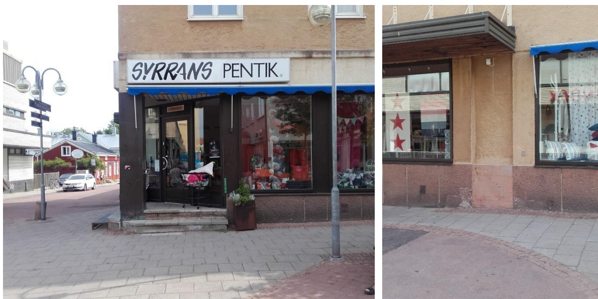
Figur 15–16: Ombyggd hörnentré från nordväst samt igensatt entré på den norra gaveln.
