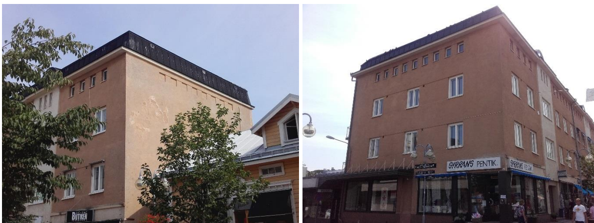
Figur 21–22: Fasad från syd och Fasad från norr
