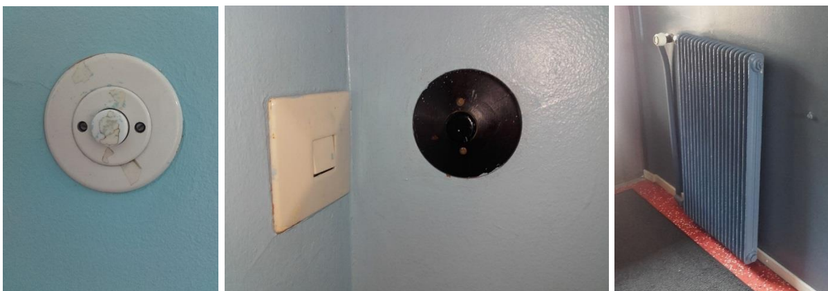
Figur 26–27: Äldre strömbrytare och värmeradiator i trapphus.
