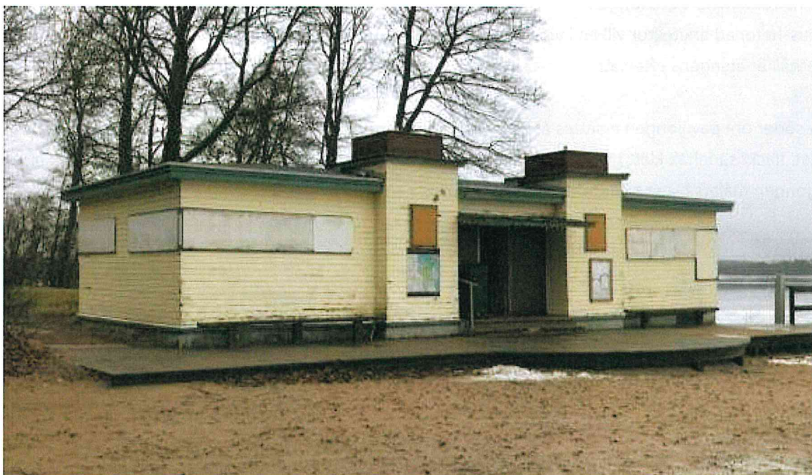
Figur 18: Omklädningshus från sydväst, 16.2.2022
