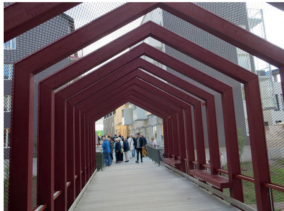
Gångbro i Vallastaden, Linköping.
