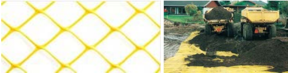
Figur 5.1. Gult geonät i närbild, respektive utlagt inför påfyllnad av rena massor på ett förorenat område. Bilderna hämtade från www.svenskageotech.se .
