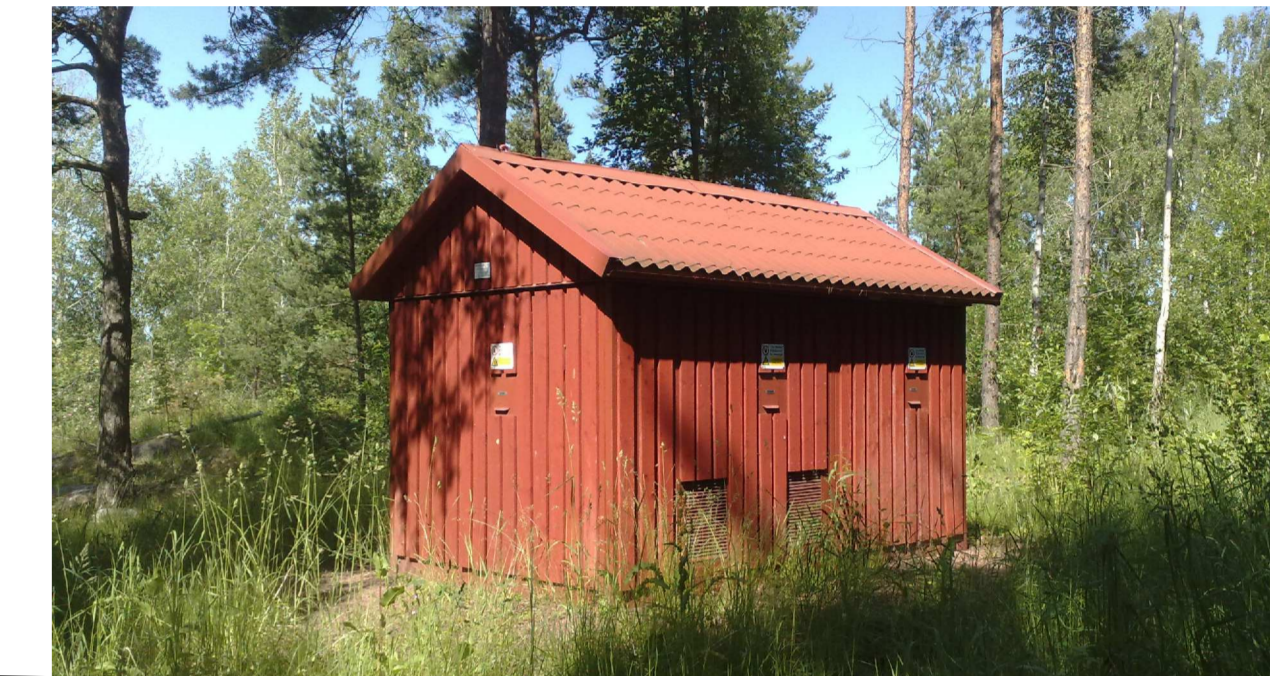
Parkens transformatorstation. Mariehamns stads egen modell. Färgsättning: tak svart, fasader grå RAL 7024.
