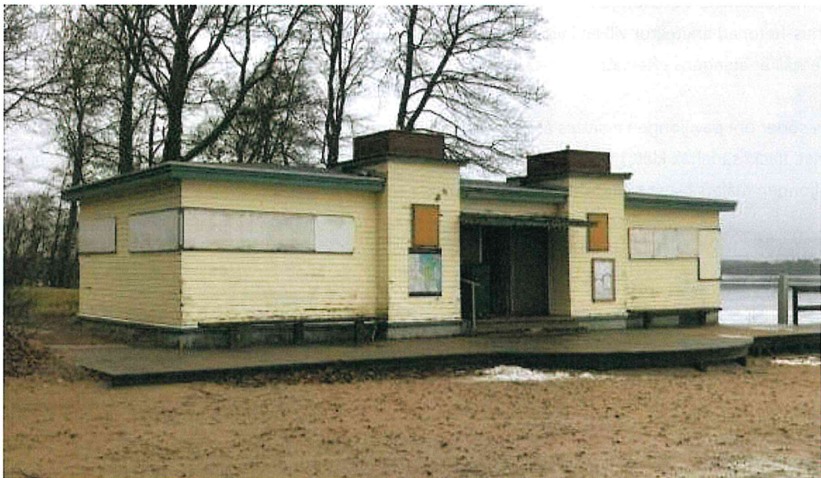
Figur 18: Omklädningshus från sydväst, 16.2.2022
