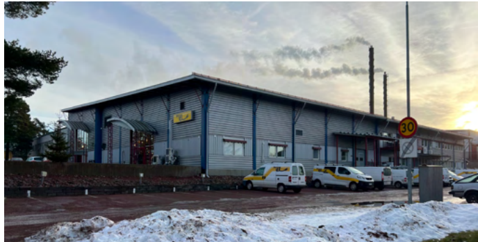
Existerande mindre industri
