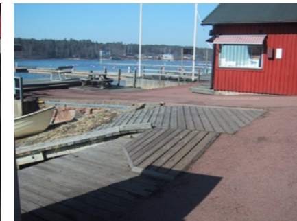
Bild 3: Båtramp kan flyttas mot Pommern med bilåtkomst till kajen. Krångliga nivåskillnader, platsen utgör ett onödigt avbrott på gångstråket längs vattenlinjen.
