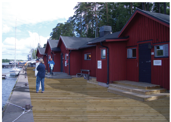
Alternativ utformning av trädeckets där den befintliga kajkanten med förtöjningsanordningar bibehålls.
