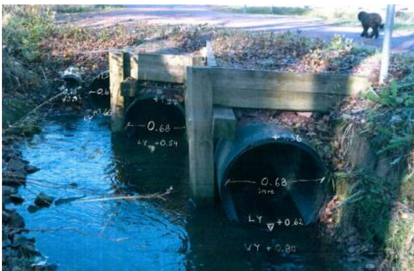
Figur 5. Strandnäsdikets inlopp i utredningsområdet. Vattenytan ligger i figuren på +0,8 m. En permanent dämning till denna nivå anses rimlig. Därtill bedöms ytan kunna höjas ytterligare 0,2 m vid högflöden. Foto: Mariehamns stad.
