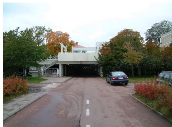
Miljöanpassad infart till underjordiska parkeringsanläggningar.
