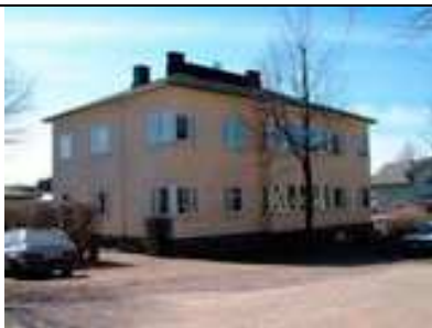
Mariegatan 11 Byggnadsår/-lovsår: 1939 Planerad av byggm. Hugo Eriksson
