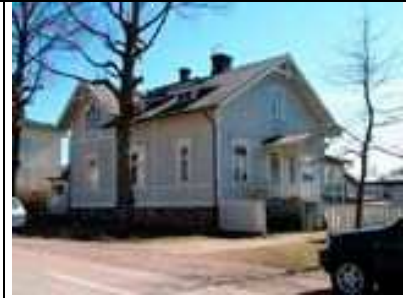
Mariegatan 13 A Byggnadsår/-lovsår: 1900 Planerad av byggm. Hilda Hongell
