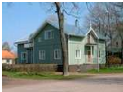
Mariegatan 36 Byggnadsår/-lovår: 1900 Planerad av byggm. Hilda Hongell
