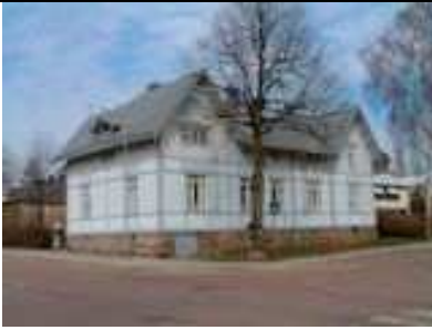
Norragatan 34 Byggnadsår/-lovår: 1907, tillbyggd på 1930-t Planerad av byggm. Hilda Hongell K-märkt 1985 Tomtbeteckning: Dalberg-4-10
