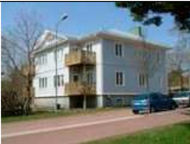
Västra Esplanadgatan 1 Byggnadsår/-lovår: 1938 Planerad av byggm. Frithiof Lindholm Kategori A Tomtbeteckning: Dalberg-4-17
