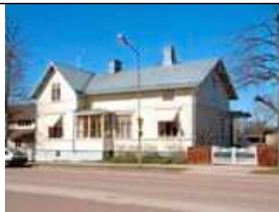
Skillnadsgatan 18 A Byggnadsår: 1899 Planerad av byggm. Hilda Hongell
