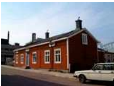
Ekonomiegatan 2 B Byggnadsår: 1866 + 1896 ?
