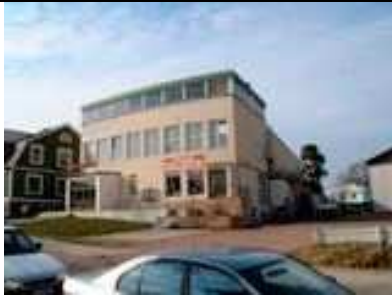
Nygatan 14 Byggnadsår/-lovår: 1939 Planerad av ark. Erik Bryggman
