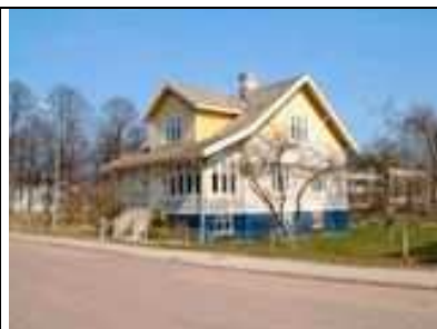
Neptunigatan 39 Byggnadsår/-lovår: 1923 Planerad av ark. Oscar Bomanson
