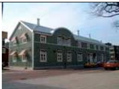
Strandgatan 12 Byggnadsår: 1866 Nuvarande utseende planerad av ark. Oscar Bomanson K-märkt 1996
