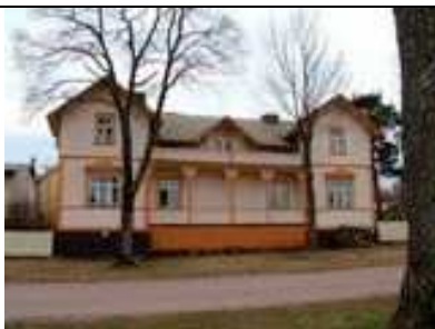
Södragatan 33 Byggnadsår/-lovår: 1891 Planerad av byggm. Hilda Hongell
