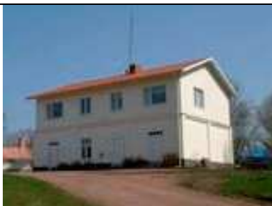
Stora gatan 23 (inne på tomten) Byggnadsår: ?, påbyggd
