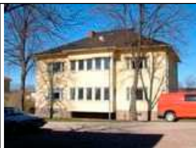
Mariegatan 8 Byggnadsår/-lovsår: 1939 Planerad av byggm. Hugo Eriksson
