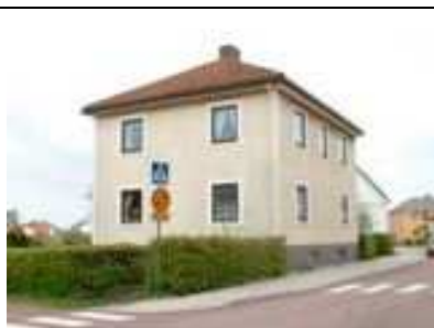
Torggatan 42 Byggnadsår/-lovår: 1943 Planerad av W Mattsson
