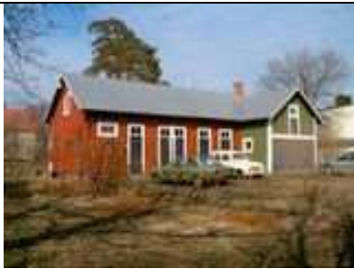
Nygatan 18, inne på tomten Byggnadsår: ?
