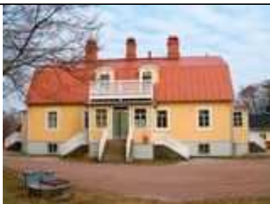
Parkgatan 24 Byggnadsår: 1928 Planerad av Jac Lundqvist
