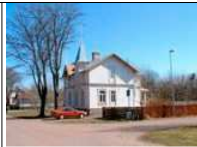
Södragatan 15 Byggnadsår/-lovår: 1898 Planerad av byggm. Hilda Hongell
