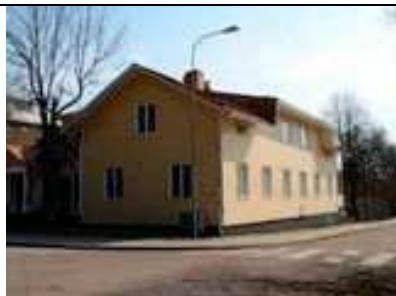
Norragatan 43 Byggnadsår: 1865, tillbyggd
