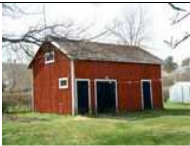
Södragatan 19 - uthus Byggnadsår: 1893 Planerad av byggm. Hilda Hongell?
