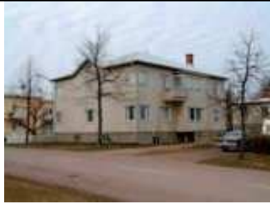
Mariegatan 4 Byggnadsår/-lovsår: 1939 Planerad av byggm. Hugo Eriksson
