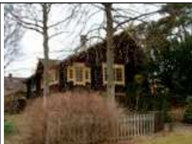
Södragatan 31A Byggnadsår: 1896 Planerad av ark. Lars Sonck som typhus
