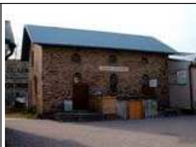
Nygatan 1 B, inne på tomten Starska magasinet Byggnadsår: 1877
