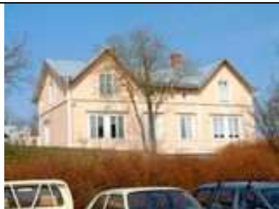
Norra Esplanadgatan 15 B Byggnadsår: 1865 + 1893 Planerad av byggm. Hilda Hongell
