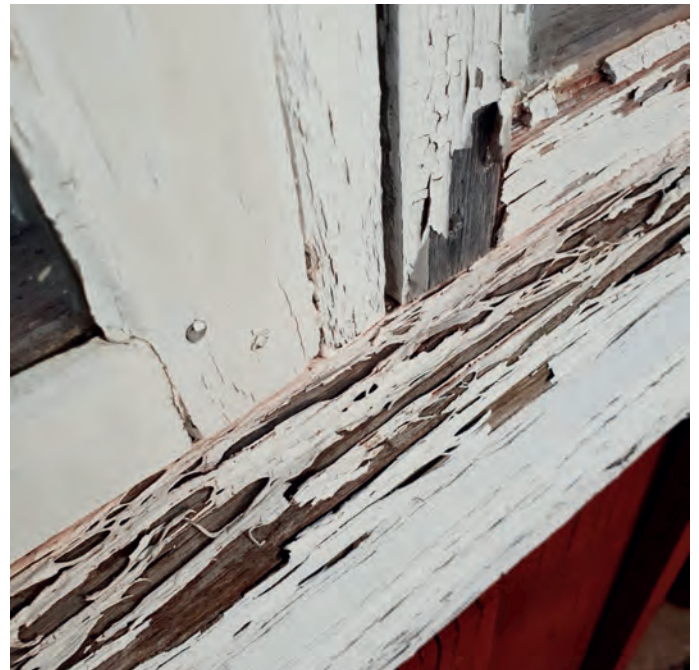
Olämpliga moderna färger flagar i större flagor, här på ett fönsterbläck av trä som inte mår bra undertill.
