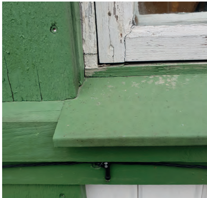
Målat fönsterunderstycke av plåt (plåtbleck) som skyddar underliggande fönsterfoder.
