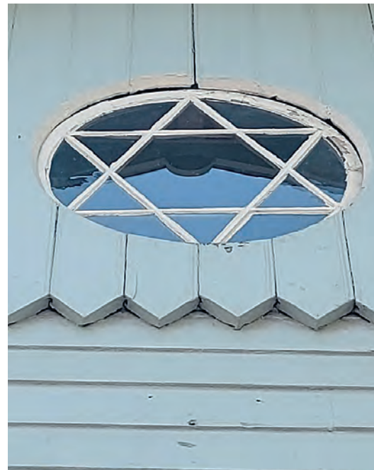
Vackert fönster, gamla rådhuset vid Esplanaden.
