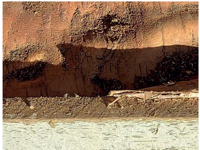
Björknäver är en bra fuktspärre mellan t.ex. fönsterkarmen och timmerstocken i ett äldre hus.
