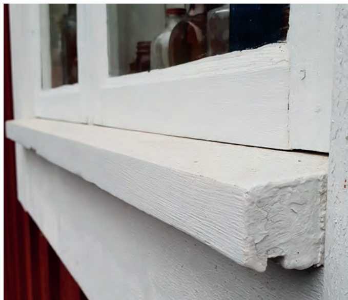
Lutande fönsterunderstycke av trä med spår undertill för att förhindra att vattnet leds mot fasaden. Målat med vit linoljefärg.
