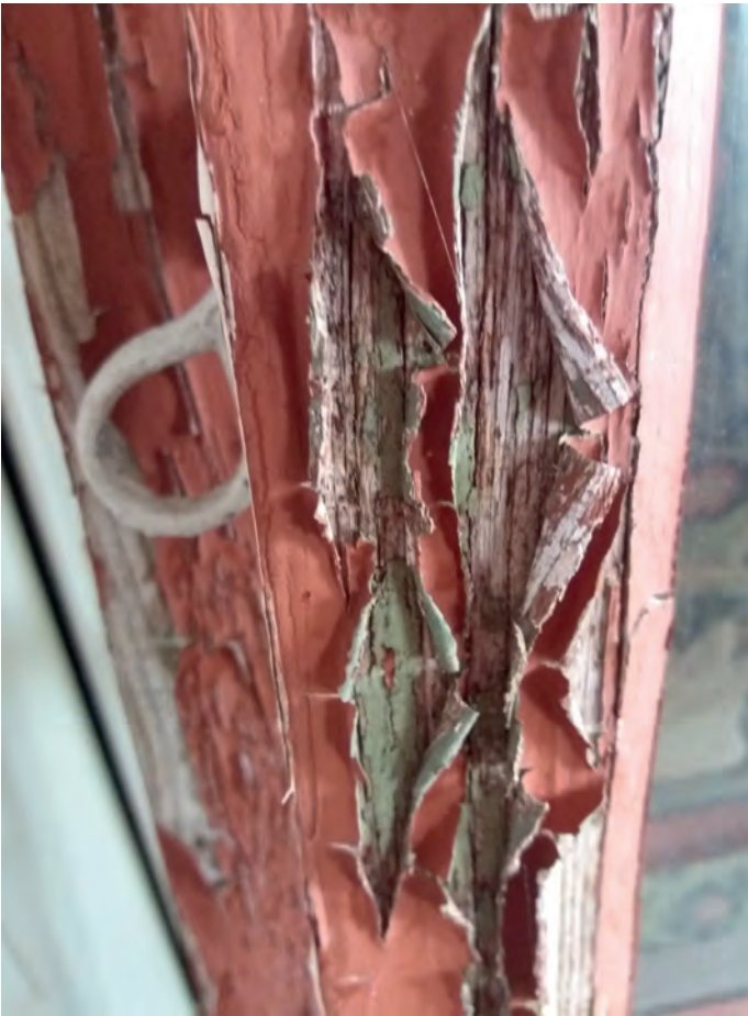
Fönsterbågar målade med olämplig färg ytterst som flagar i stora flagor. Underst sannolikt linoljefärg.
