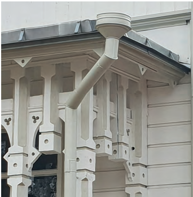
Vattkupa med hög sarg, stuprör med skarpa vinklingar och målad i bakomliggande fasadfärg.
