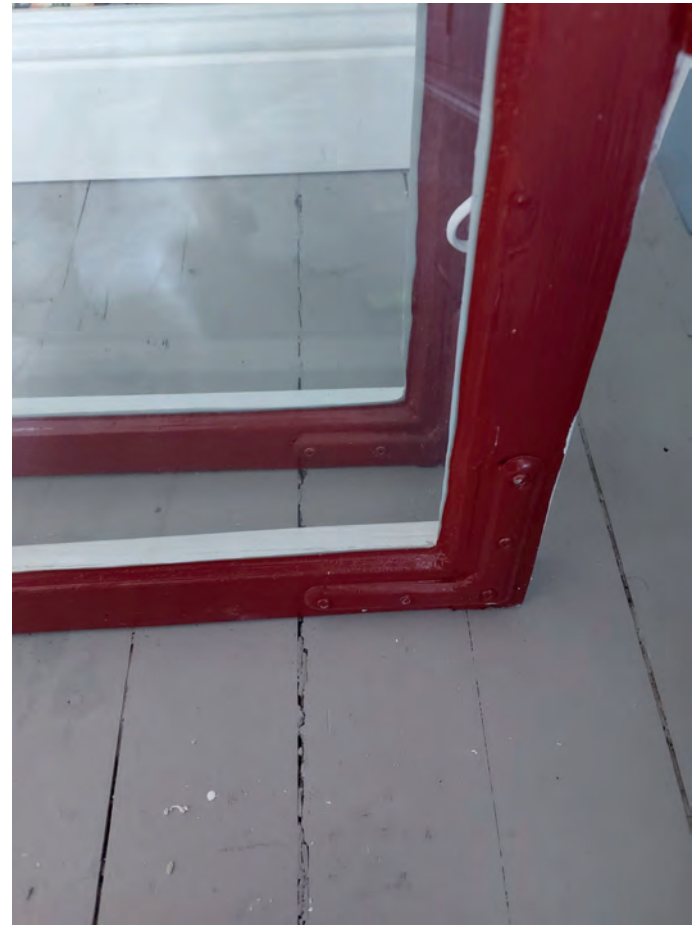
Samma fönsterbågar renskrapade och åter målade med äkta linoljefärg.
