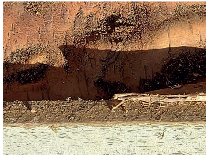
Björknäver är en bra fuktspärr mellan t.ex. fönsterkarmen och timmerstocken i ett äldre hus.
