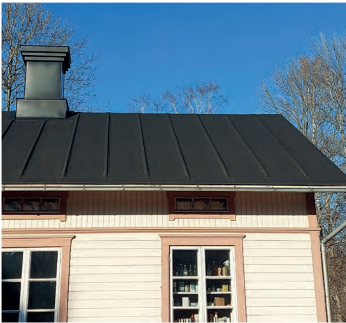
Filttak med trekantslist på Köpmannamuseet i Mariehamn byggt 1885. Huset är flyttat. K-märkt år 2014.
