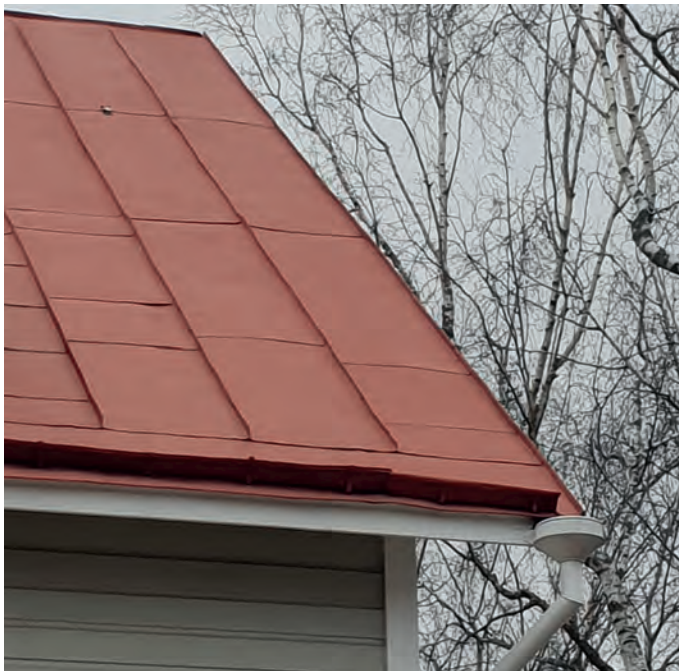
Falsat plåttak som är skivtäckt. Längst ner på taket finns en fotränna av plåt i stället för hängränna.
