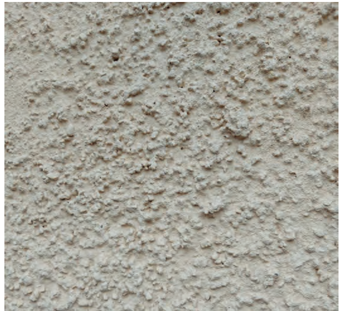
Ljusbultsputs, en vanlig fasadtyp på hus i Mariehamn. Kalkfärg förutsätter underliggande kalkputs.
