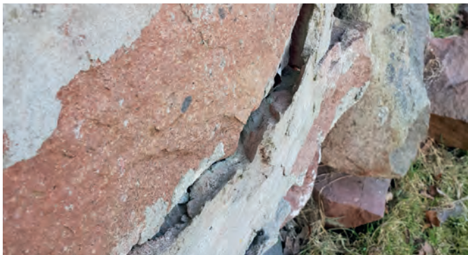
Stenfot med cementbruk i fogarna där cementen lossar i stora skivor.
