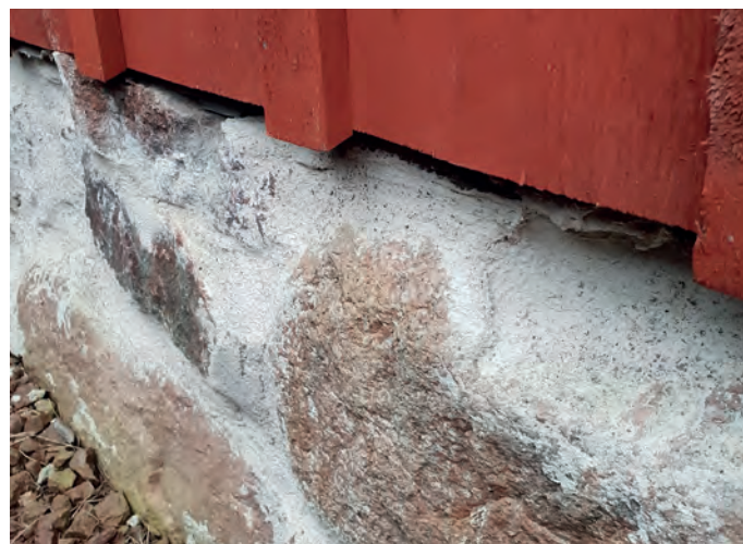
Stenfot med kalkbruk i fogarna gör stengrunden mer eftergivlig. Stengrunden i liv med ytterpanelen.
