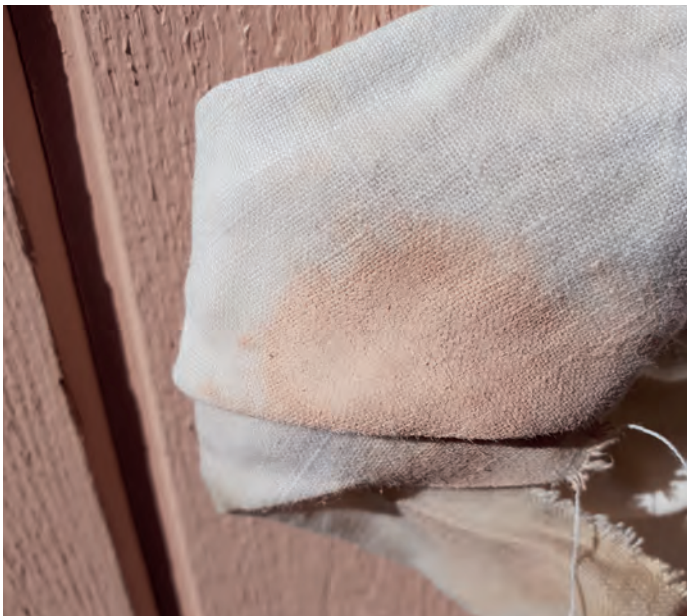
Rödsprit har gnuggats mot fasad målad med akrylatfärg och då börjar färgen smeta.
