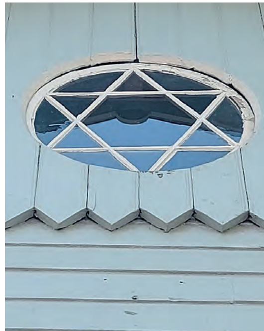
Vackert fönster, gamla rådhuset vid Esplanaden.
