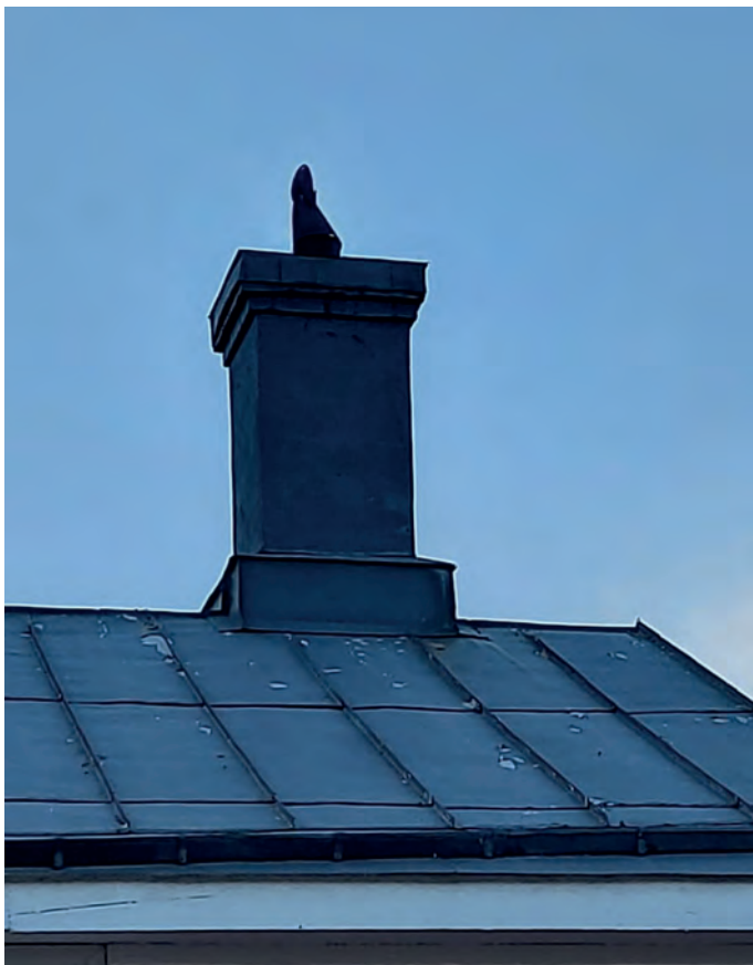
Plåtbeklädd skorsten med krön upptill på K-märkt hus i Mariehamn från andra halvan av 1800-talet. Skivtäckt falsat plåttak.
