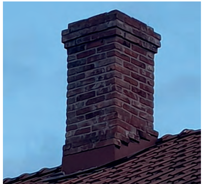
Murad skorsten av tegel och nederbeslag av plåt (plåtkrage). Det är viktigt att skorstenen är tät mot takmaterialet.
