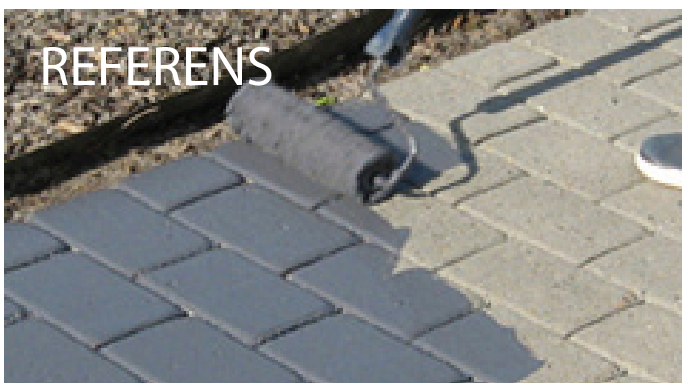
Målning av gatsten är vanligt för att återfå färgen då den vattnats ur. Bild: F Wästsvenska Takmåleri AB.
