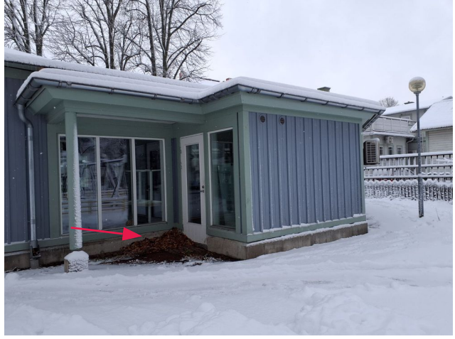
Överblicksbild fasad mot öster. Kom ihåg att rensa bort löv som samlas mot byggnaden.
