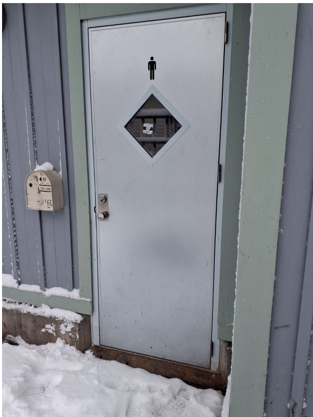
Plåtdörrar vid toaletterna
