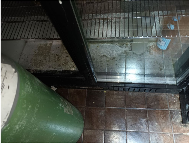
Mögelpåväxt i ett av kylskåpen vid baren.
