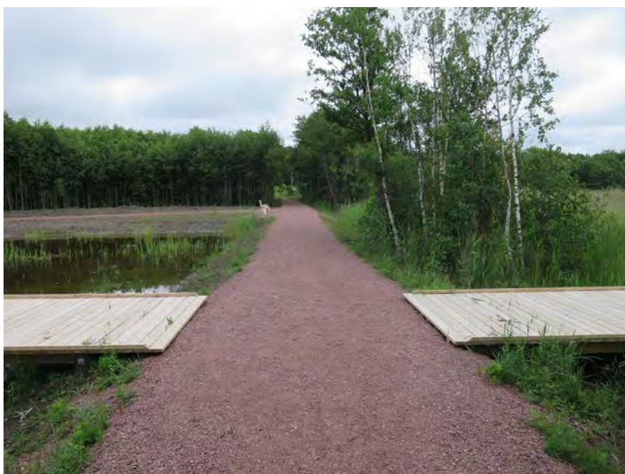
Ramperna till de två bryggorna är än så länge svåra att ta sig upp på för en rörelsehindrad. Detta åtgärdas under 2023.
