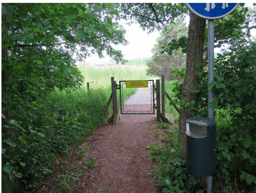
Svängrumsytan runt grindarna är mindre än 2,3 x 2,3 m.
